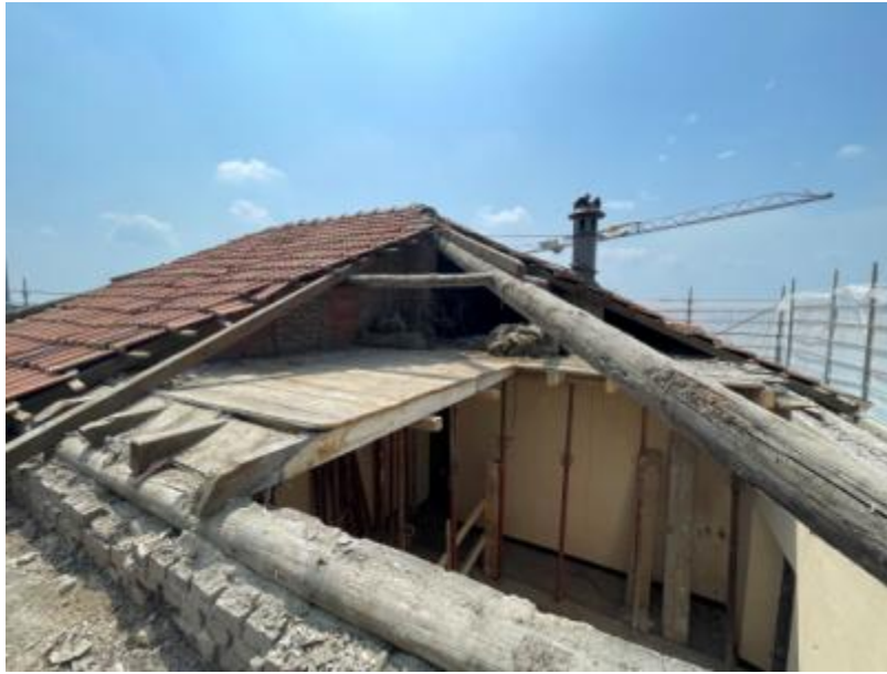
Foto scattata durante le operazioni di demolizione della copertura dell'edificio
