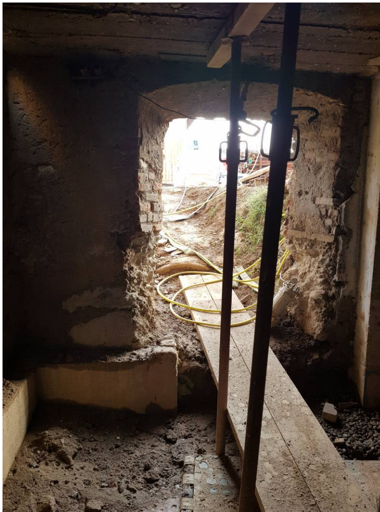
Foto che attesta l'entità dello scavo e delle demolizioni realizzate
