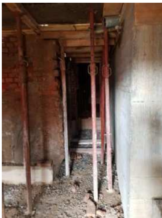
Foto da cui si evince la natura della scarifica per allargamento varchi esistenti
