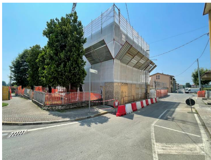
Via Adda – Situazione a seguito della posa in opera del ponteggio e dello spostamento del palo (data 11/07/2023)
