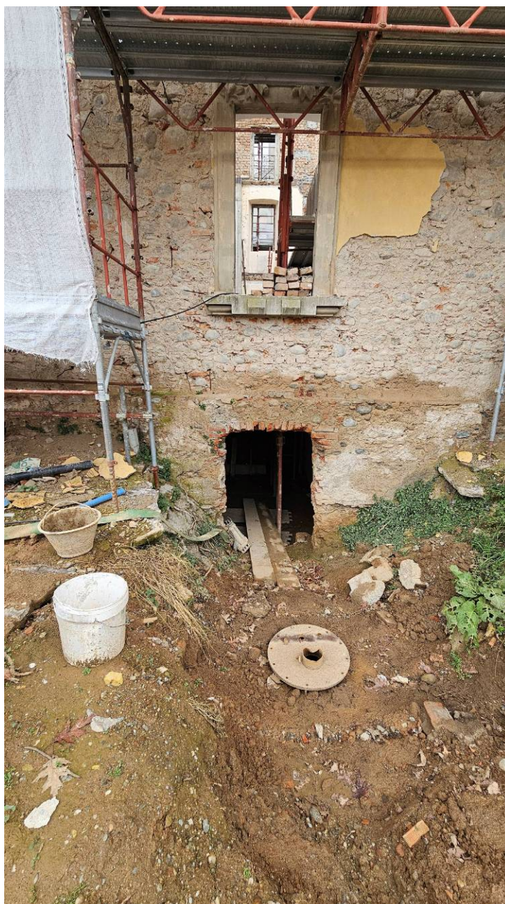
Foto che attesta l'entità dello scavo e delle demolizioni realizzate
