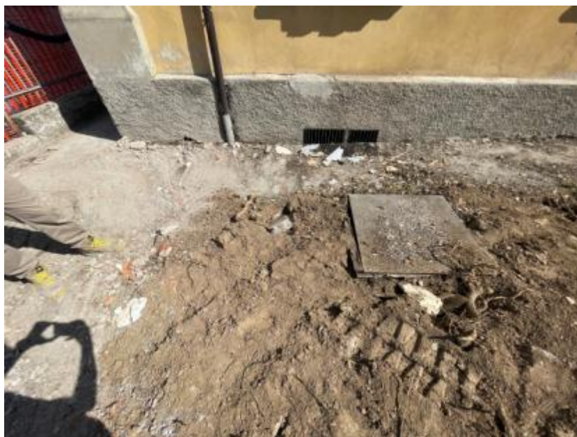
Foto scattata prima della realizzazione delle lavorazioni
