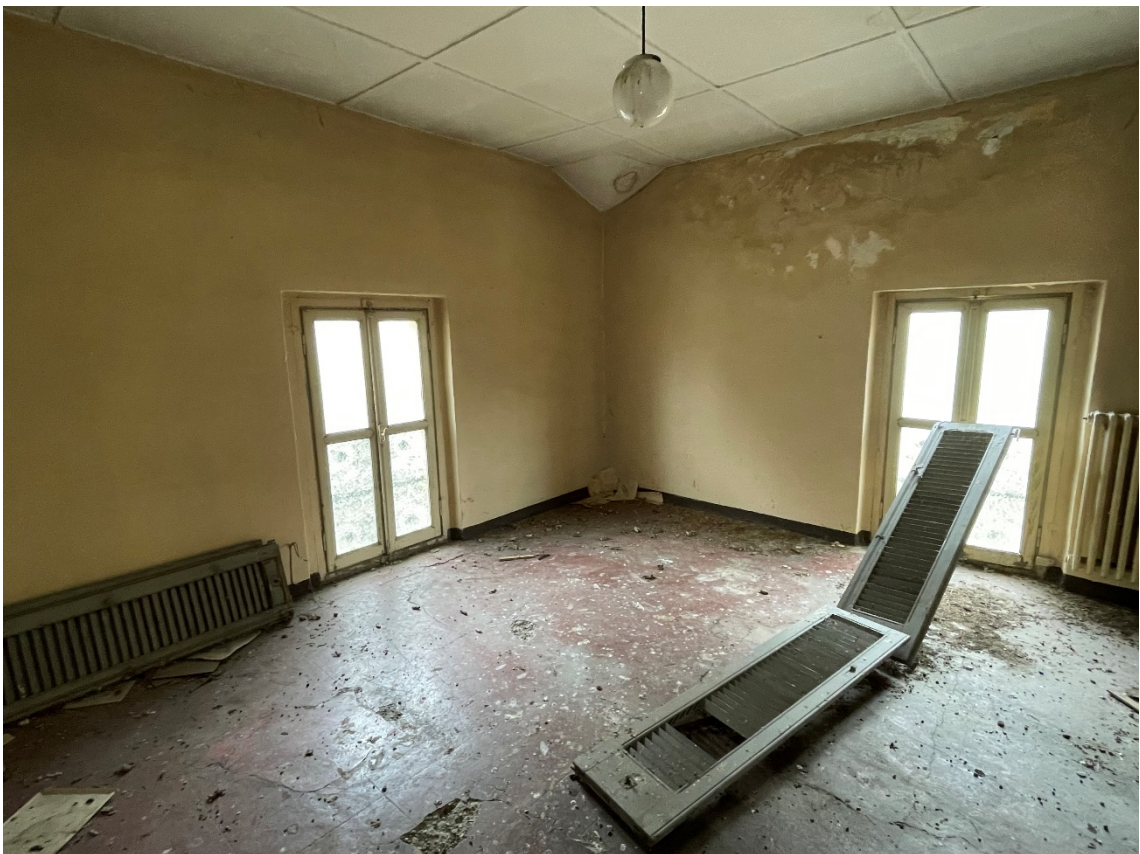
FOTO N. 9: LOCALI INTERNI AL PIANO SECONDO
