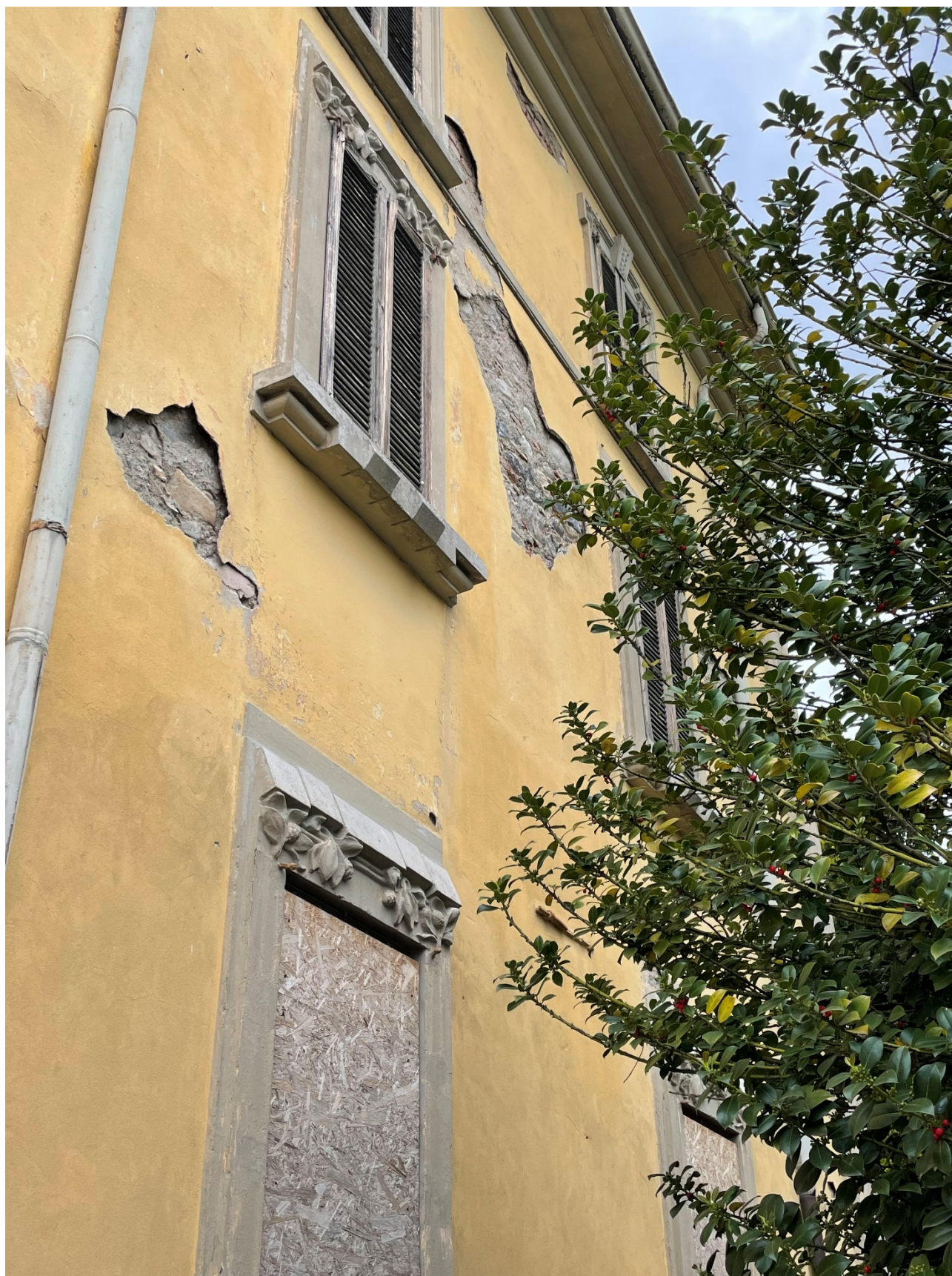
FOTO N. 15: DETTAGLI FACCiate ESTERNE
