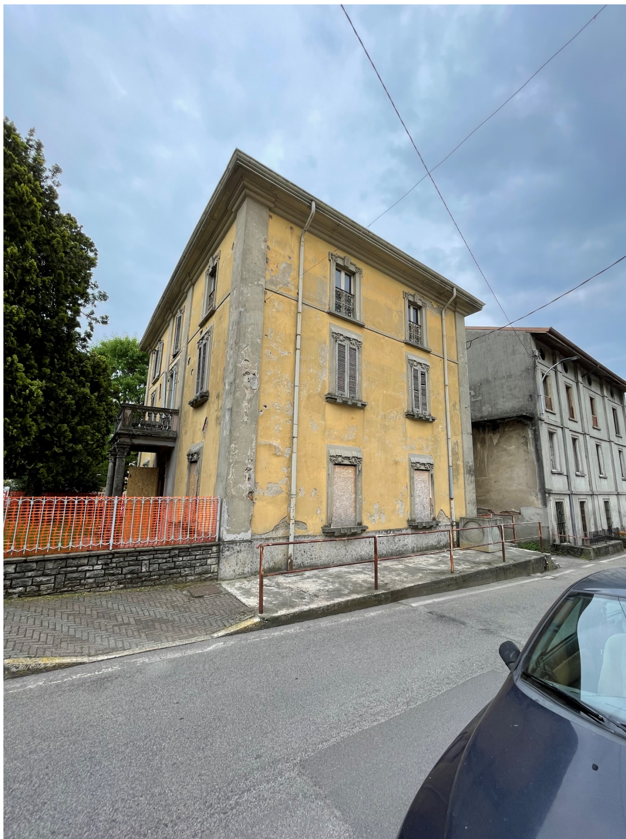
FOTO N. 2: VISTA LATO NORD
