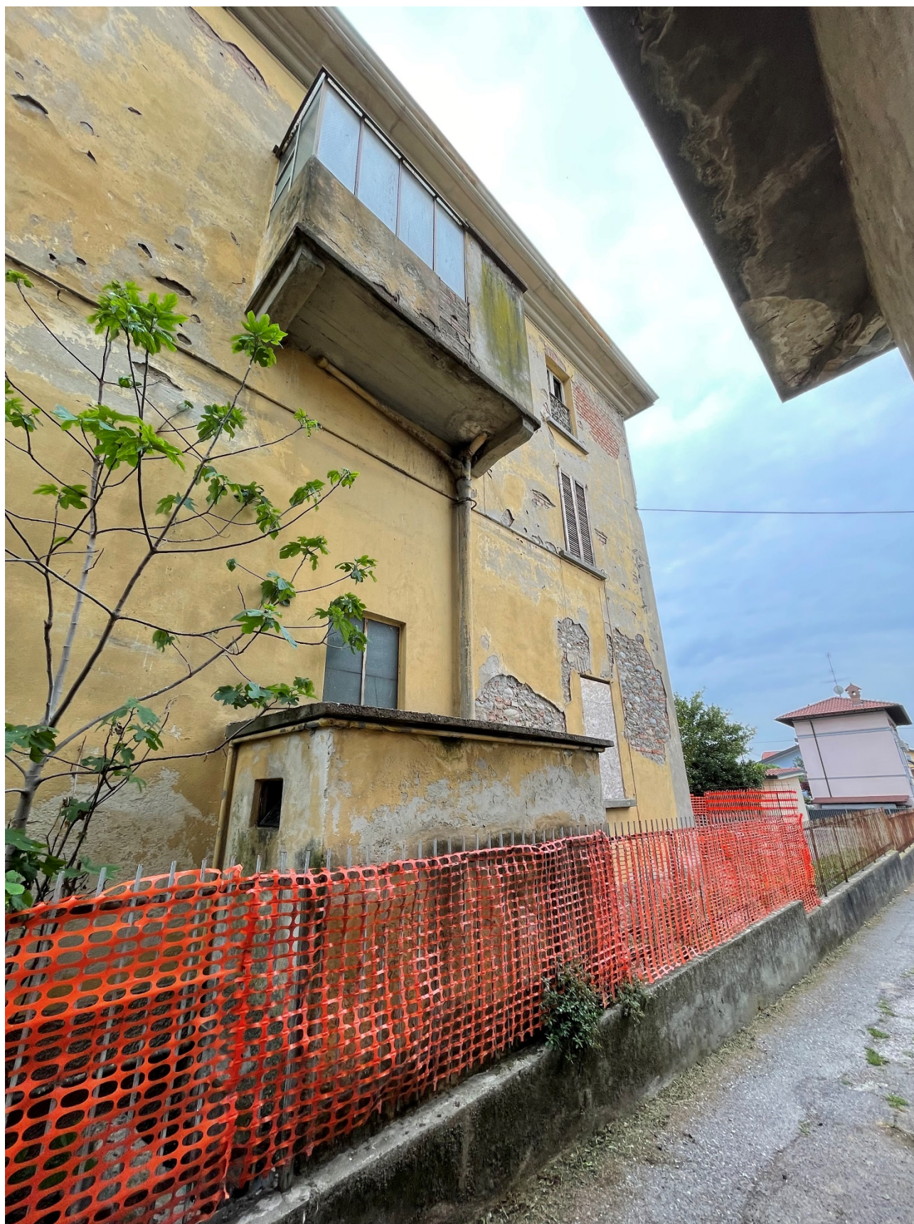
FOTO N. 4: VISTA LATO OVEST
