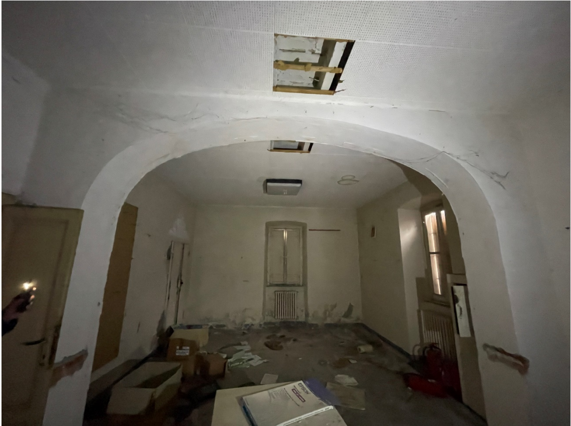
FOTO N. 5: LOCALI INTERNI AL PIANO TERRA
