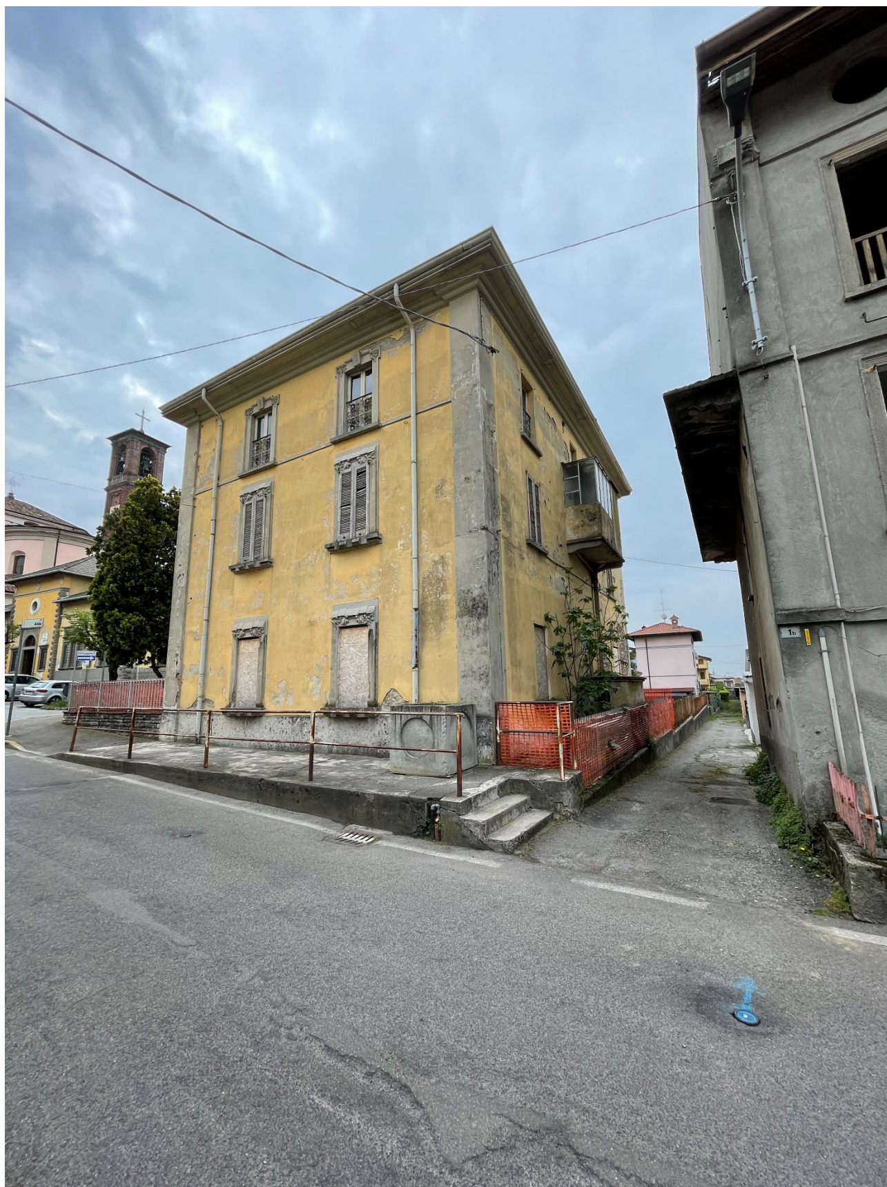
FOTO N. 3: VISTA LATO NORD
