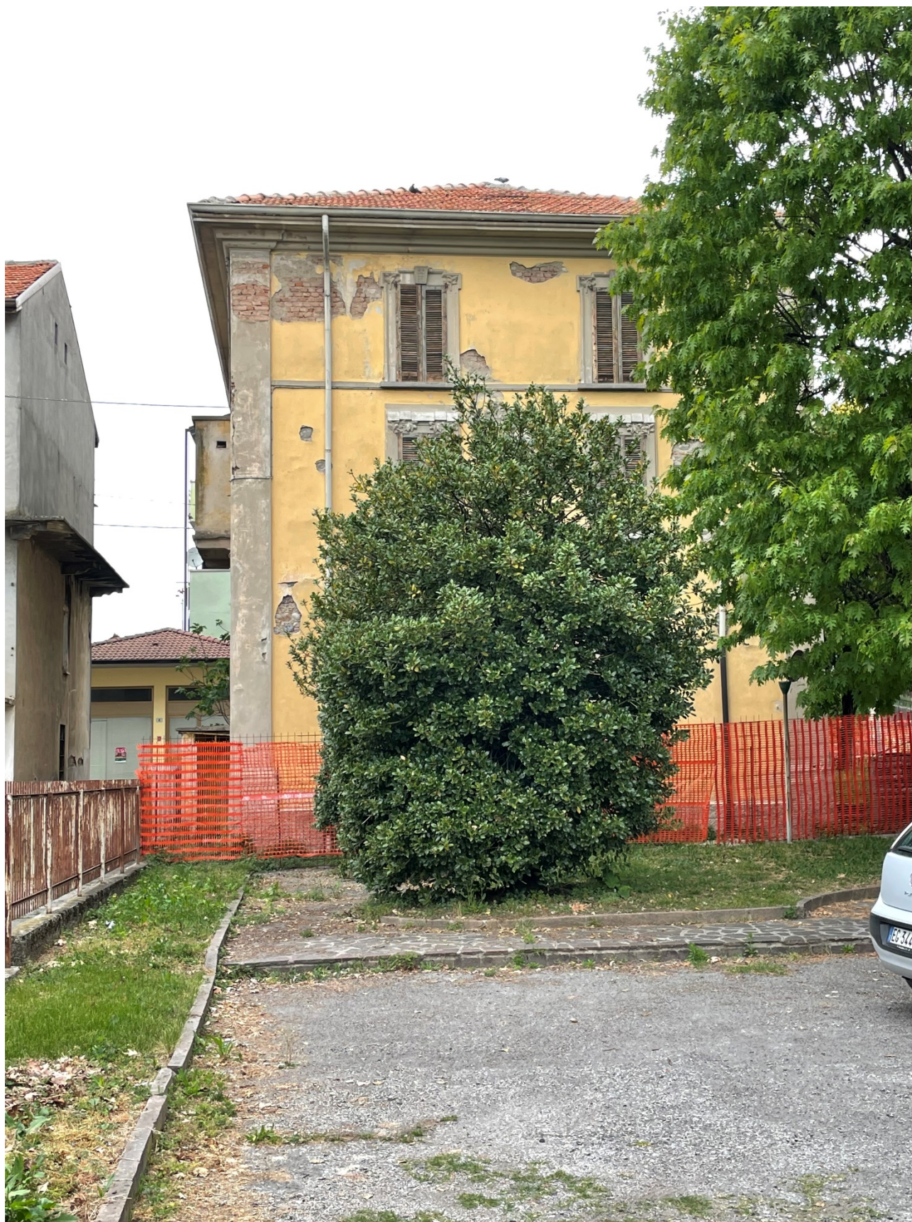
FOTO N. 14: VISTA LATO SUD E AREE ESTERNE
