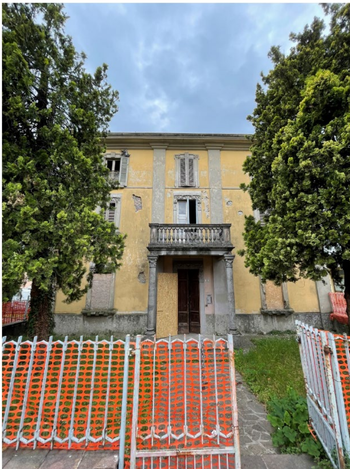
FOTO N. 1: VISTA INGRESSO PRINCIPALE
