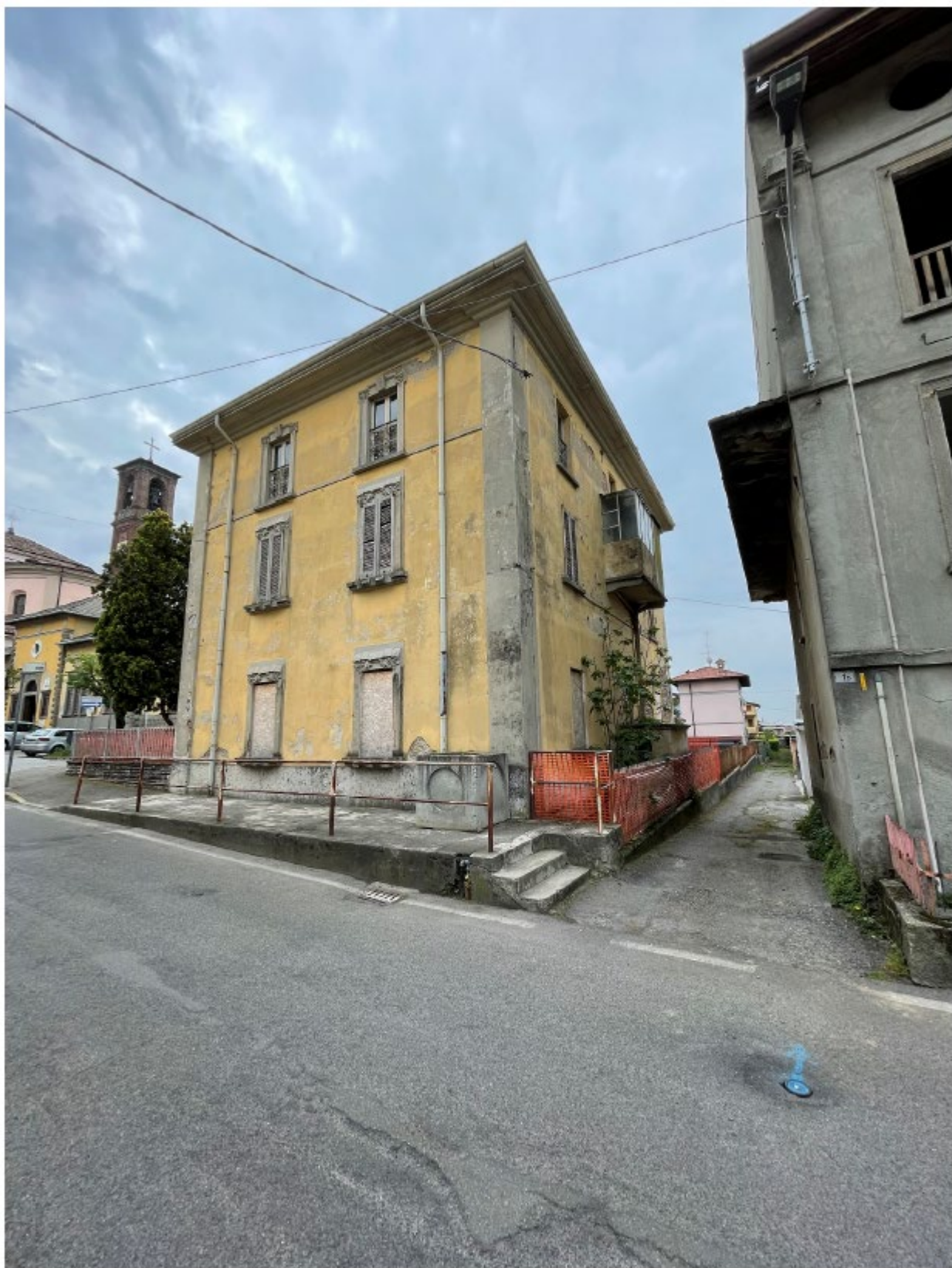
FOTO N. 3: VISTA LATO NORD
