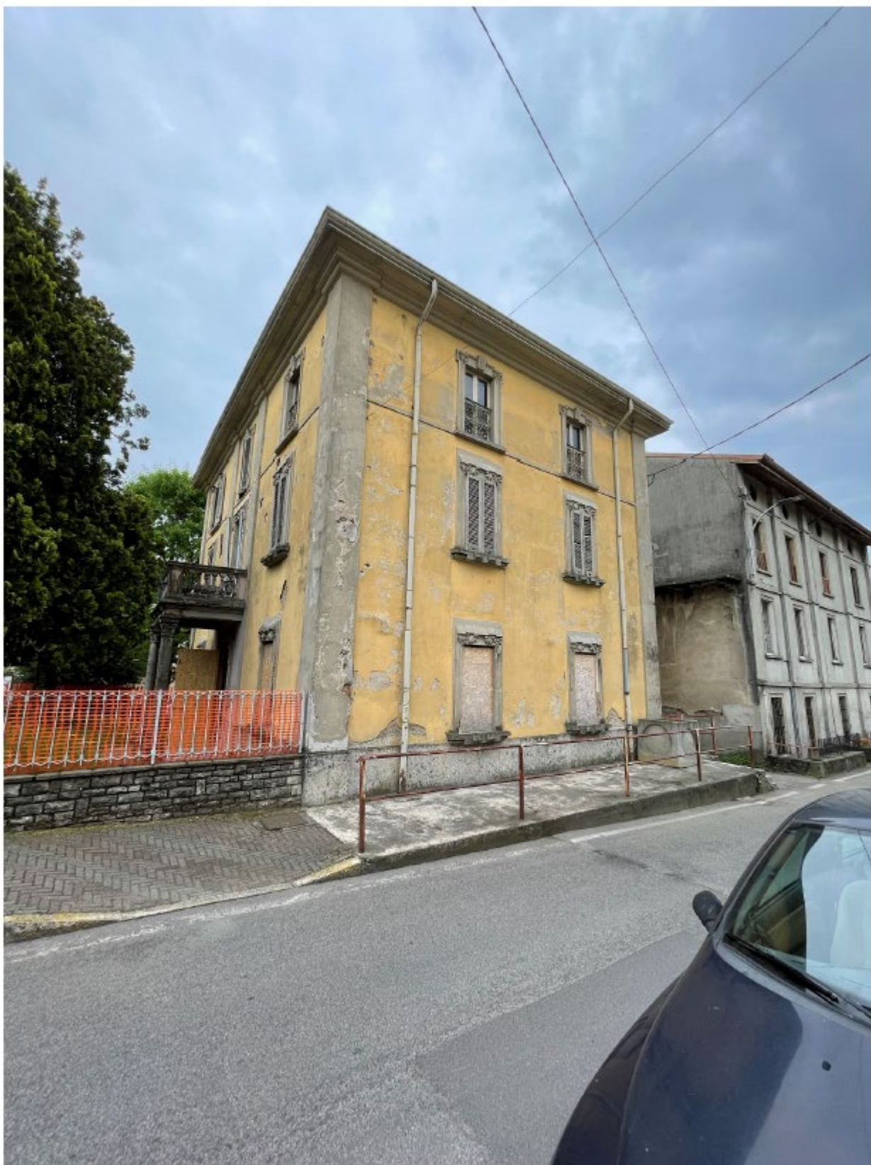
FOTO N. 2: VISTA LATO NORD
